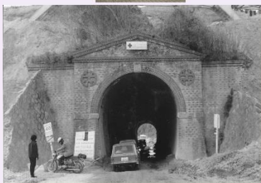
旧関西鉄道大仏線黒髪山トンネル(奈良側)取壊し工事中 山は削られ、新し鉄橋の橋脚が見える。 昭和 41 年（1966）3 月 20 日撮影：木村守男氏
